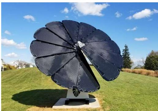
I pannelli fotovoltaici devono essere montati su appositi supporti in modo da garantire sempre la migliore esposizione possibile alla luce; sono stati inoltre sperimentati moduli a supporto girevole del tipo "a girasole", che consentono ai pannelli di ruotare alla ricerca di condizioni ideali di esposizione, imitando il comportamento naturale dell'omonima varietà di fiori.
