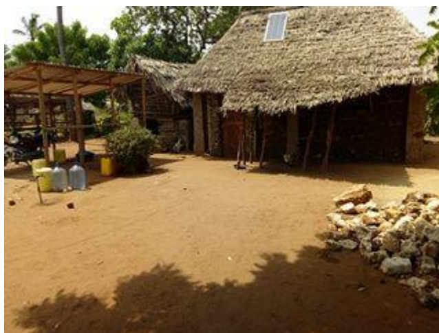
Casa di un amico keniota costruita con fango, legno e foglie di agave intrecciate dotata di pannello solare
